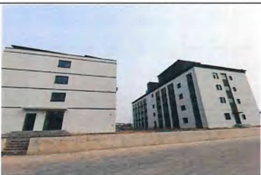
综合楼及检验楼
