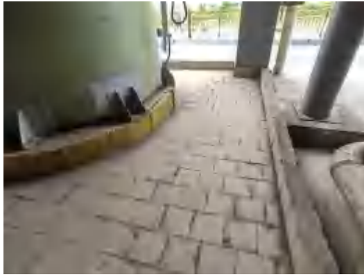
水洗塔、酸洗塔围堰
