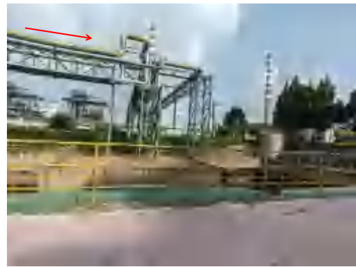
新型催化法烟气脱硫装置至 3#、4#焦炉脱硫脱硝系统的管道
