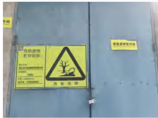
危废间贮存设施标志牌+双锁
