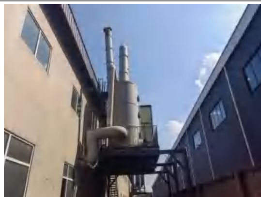
冷凝+碱雾、酸雾吸收净化塔
