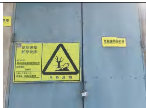
危废间贮存设施标志牌+双锁
