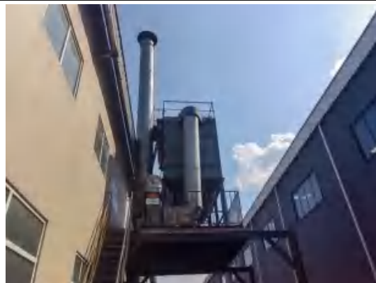
冷凝+碱雾、酸雾吸收净化塔
