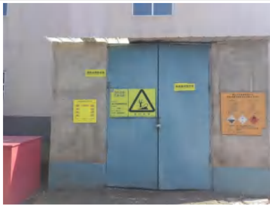
危险废物暂存间
