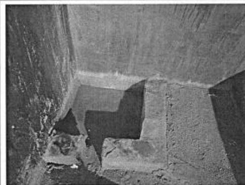
危废间集液池
