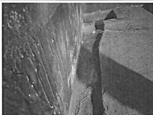
危废间导流沟
