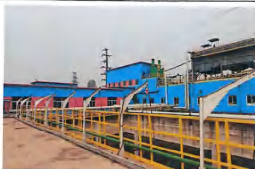
厂区污水处理站
