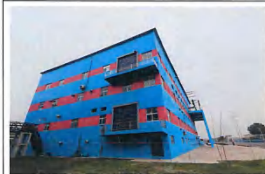
新建轧一钢铁 220kV 变电站
