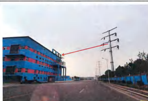
新建轧一钢铁 220kV 变电站进线
