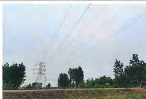
项目线路-跨越彭李公路
