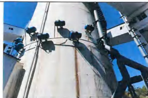
辊前仓废气收集
