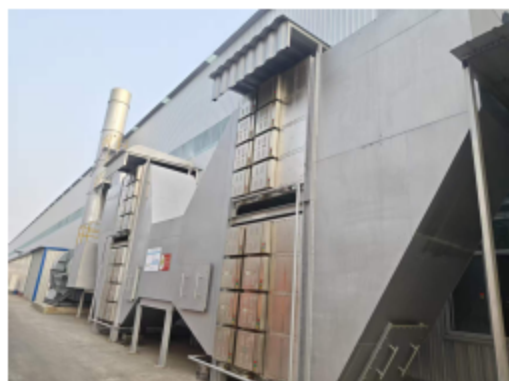
图 5 废气处理设施及排气筒照片
