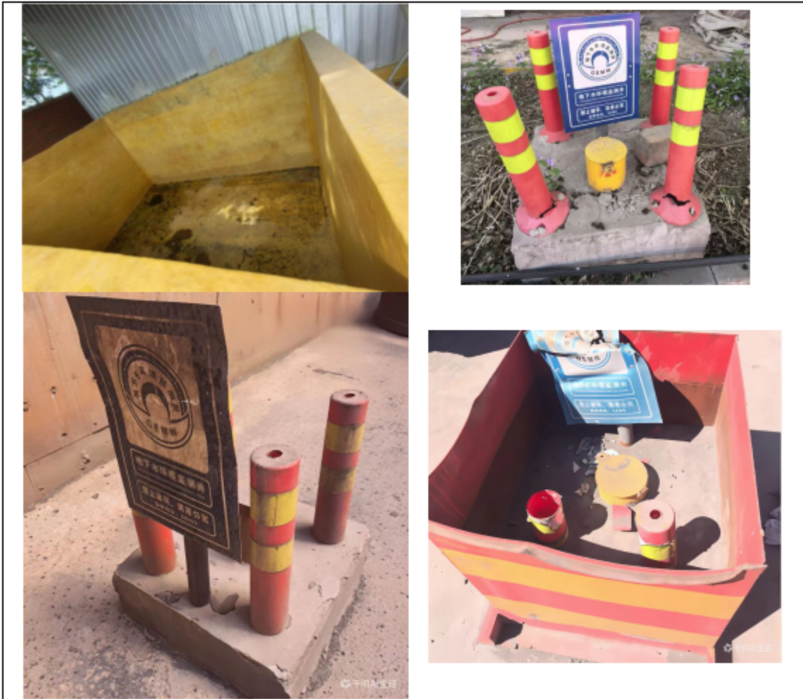
图 7 应急池及地下水监测井照片
