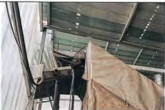
生产线物料转运点喷雾抑尘
