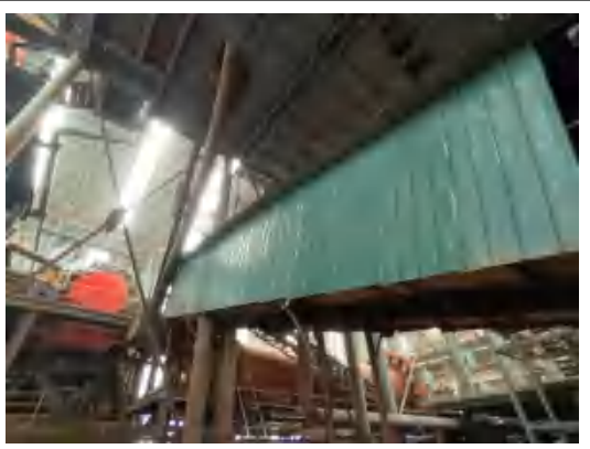
皮带封闭通廊
