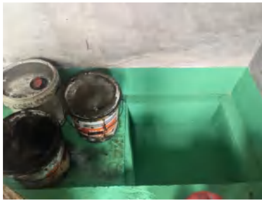
危废间集液池
