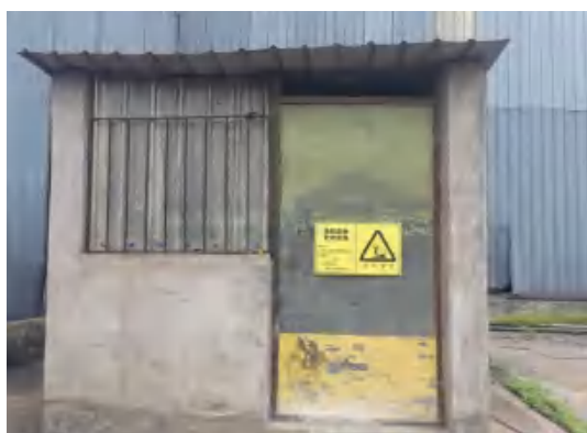
危险废物暂存间
