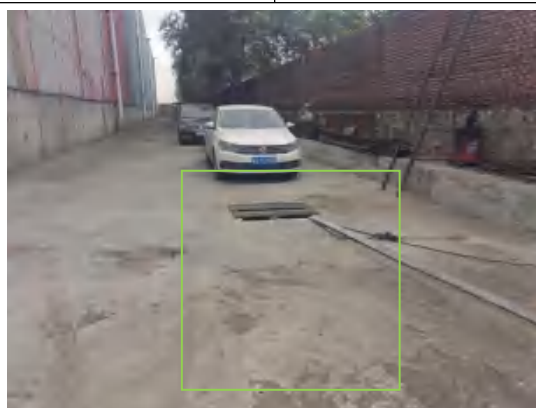
初期雨水收集池
