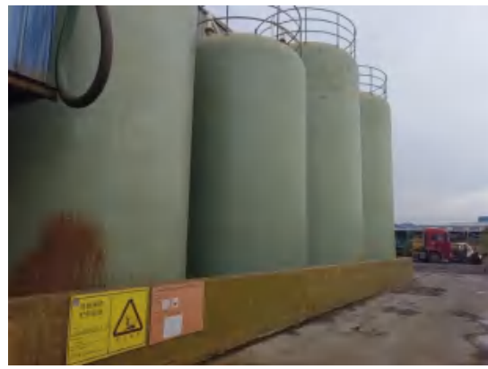
罐区玻璃钢防渗及围堰
