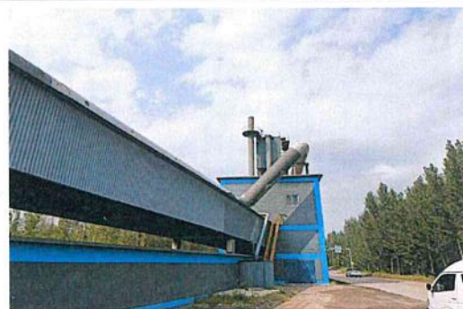
9#转运站除尘+排气筒
