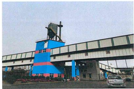
K2 转运站除尘+排气筒
