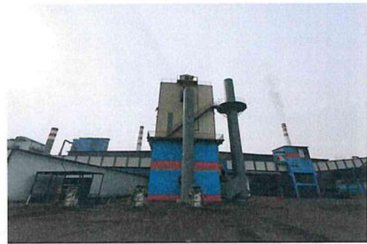
K5 转运站除尘+排气筒
