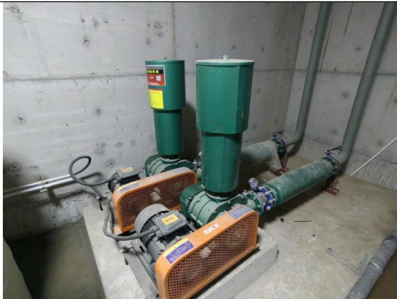
基础减振+地下隔声
