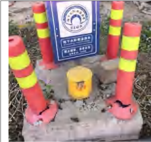
地下水监测井
