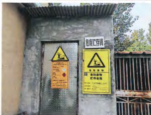
危险废物暂存间
