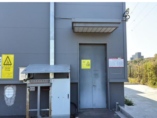
危险废物暂存间
