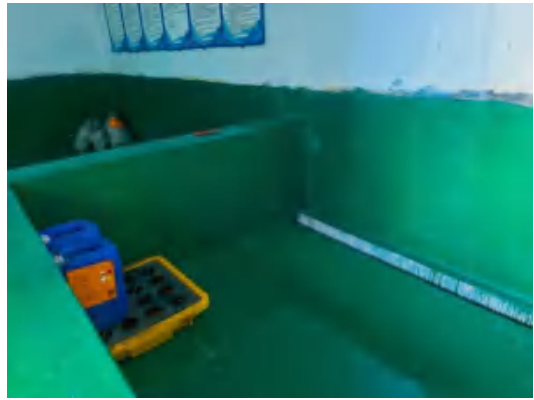
危废间内地面分区
