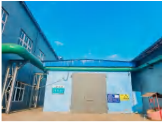
危险废物暂存间
