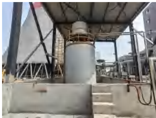
氨罐区围堰
