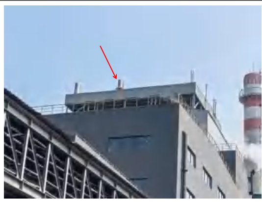
排汽孔安装小孔消音器
